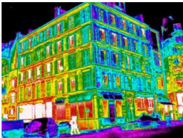
Un immeuble du 19 e siècle thermographié, dans le 9 e arrondissement
